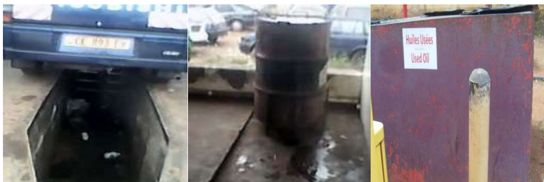
Photo 1.1: fosses étanches de stockage des huiles
